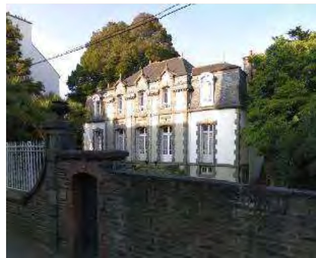
VILLA - 10, Boulevard de la Gare
