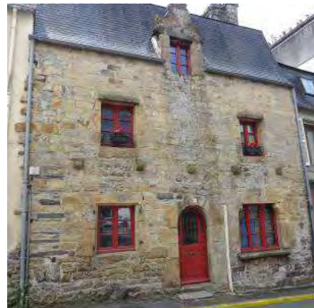
MAISON URBAINE XVII ÈME - 40, rue des Déportés
