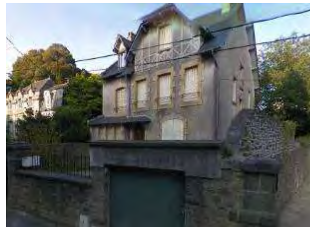
VILLA - 8, Boulevard de la Gare
