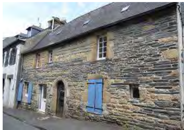
MAISON URBAINE XVII ÈME - 35 rue des Déportés
