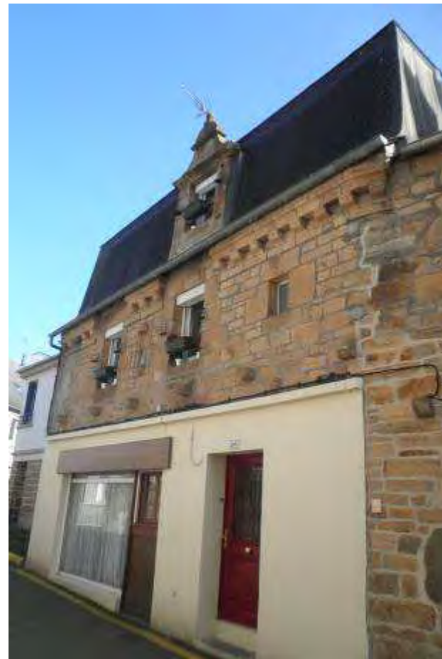
MAISON URBAINE XVII ÈME - 26, rue des Déportés
