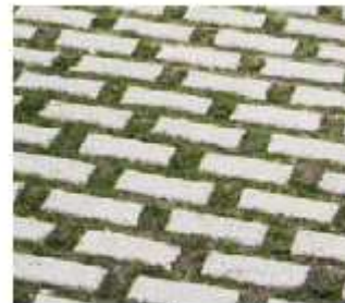
Pavage en béton avec ouvertures de drainage
