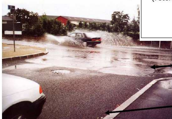
Chaussée à structure réservoir, Craaponne (CERTU - 1994)
