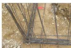
Noeud de chaînage - Continuité mécanique
