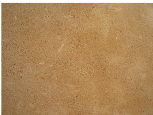
exemple d'enduit de finition à la chaux
