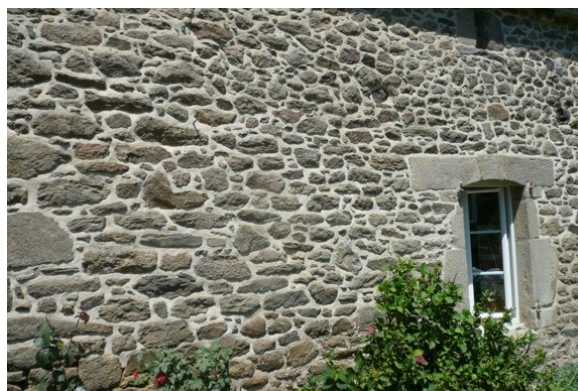
exemple de joints extérieurs chaux/sable
