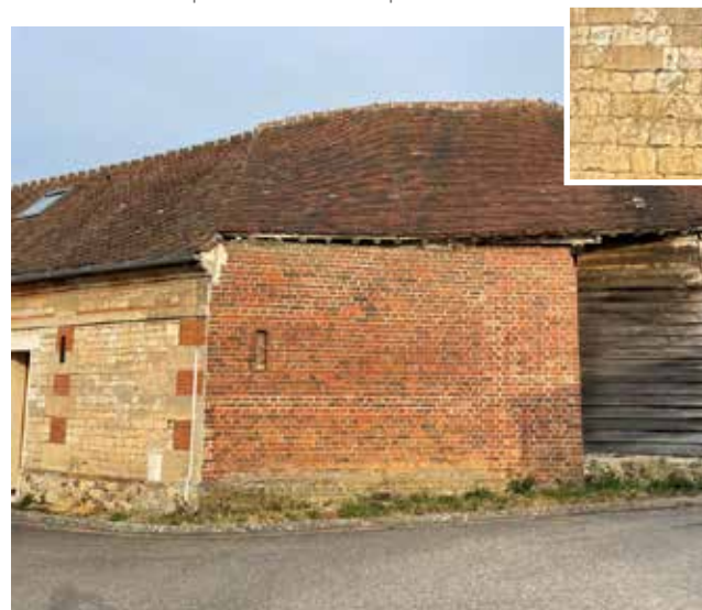
Moellons de grès, briques et bois à Fouquerolles
