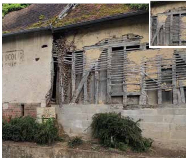
Utilisation du torchis pour combler des pans de bois et soubassement en brique (pour partie) à Fontaine-Saint-Lucien
