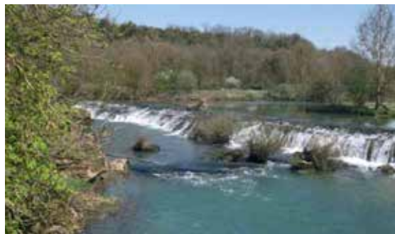
Un seuil, exemple de discontinuité dans le fonctionnement du cours d'eau
