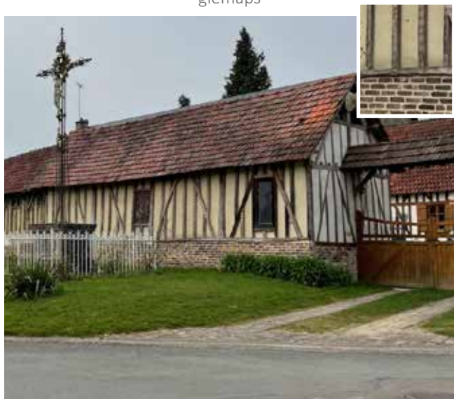
Torchis, colombages et soubassement en briques à Berneuil-en-Bray
