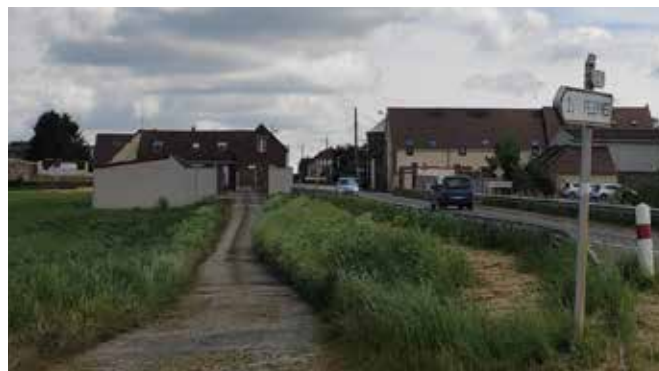
Entrée de ville à Fouquerolles - entrée via la RD938 à la dimension routière marquée (absence de trottoirs, présence de glissières de sécurité, trafic...) et vue sur l'alignement des constructions caractéristique des bourgs
