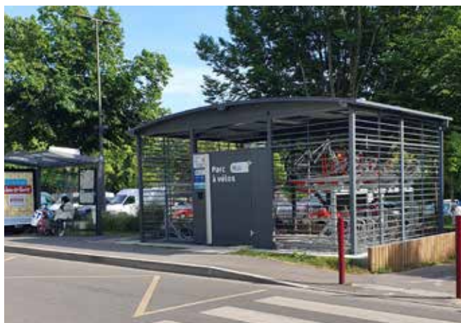
Parc à vélos de la CAB et arrêt de bus à proximité
