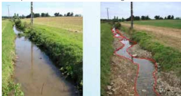
Exemple de travaux de reméandrage
