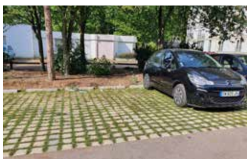
Stationnement désimperméabilisé à Beauvais (quartier Argentine)
