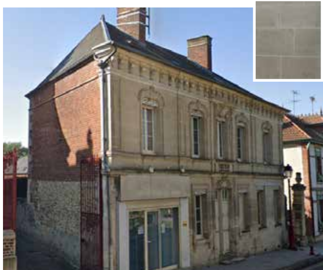
Utilisation de la pierre calcaire en façade sur rue et de la brique en partie haute du pignon à Hermes - Source : googlemaps
