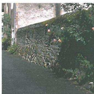
Les clôtures traditionnelles du bourg sont maçonnées, couronnées par un chaperon arrondi.
