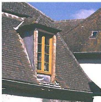
Une lucarne traditionnelle est de proportions nettement plus haute que large, ce qu'oublie parfois ceux qui dimensionnent la lucarne à partir d'un châssis de fenêtre type...
