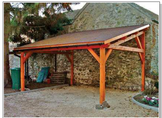
Abri de protection accolé à bâtiment (adjonction)
