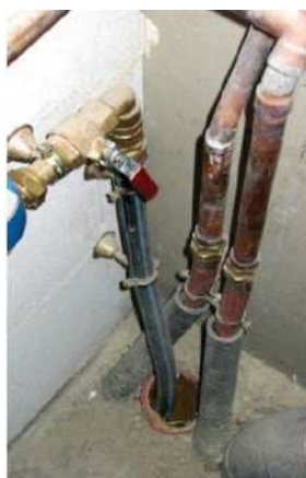
Exemple d'entrées de réseaux à calfeutrer
