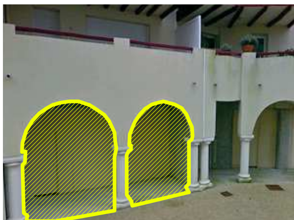
Obturation d'une travée de galerie
