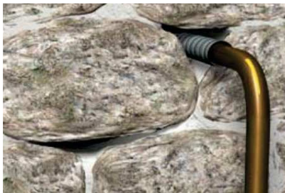
Situation initiale avant colmatage
