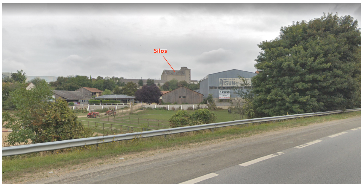
Vue depuis la RD 912 (en arrivant de l'Ouest)
