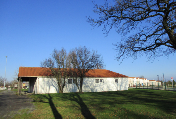
Bâtiment délaissé au Nord-Est
