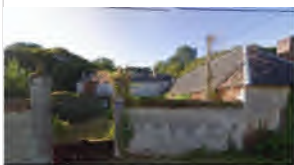
Patrimoine remarquable – rue de Grenouilly
