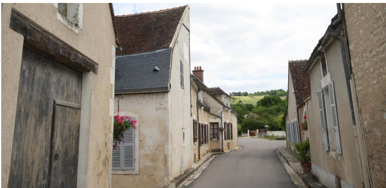
7. Vue depuis la rue Saint-Martin
