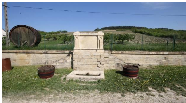
Réserve incendie face au cimetière
