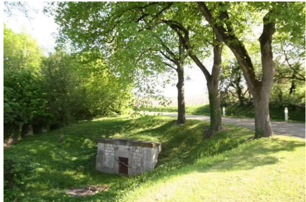
Station de pompage – entrée Est
