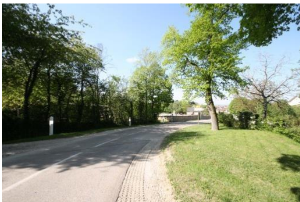
Entrée Est par la RD38
