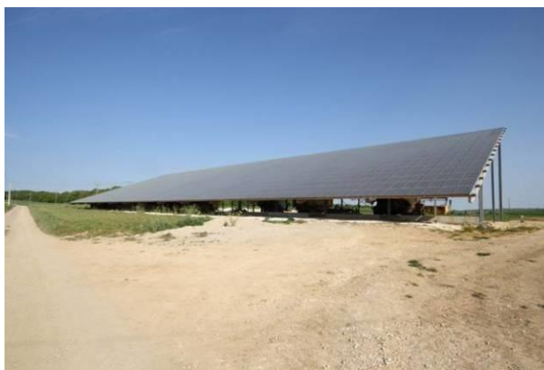
Le nouveau hangar recouvert de panneaux photovoltaïques
