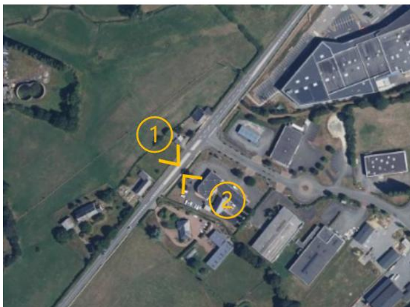
Vue aérienne de l'insertion de la zone 1AUEM dans son environnement avec les points de vue (photographies ci-dessous), source : geoportail
