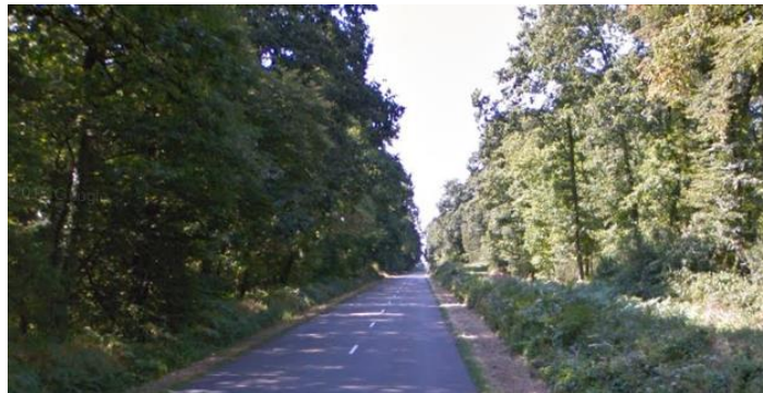
Traversée du Bois d'Hermet, Mézangers (Source : Google Maps)
