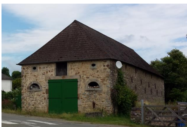
Bâtiment agricole - Ste-SUZANNE
