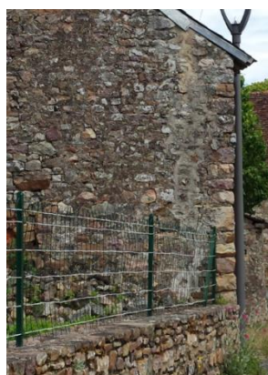
Utilisation de grès sans enduit apparent, Sainte-Suzanne (Source : Even Conseil)
