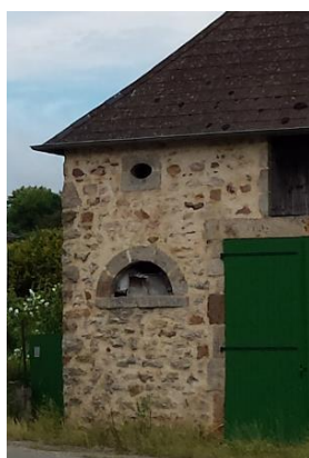
Utilisation de grès et enduit de chaux en façade, Sainte-Suzanne (Source : Even Conseil)
