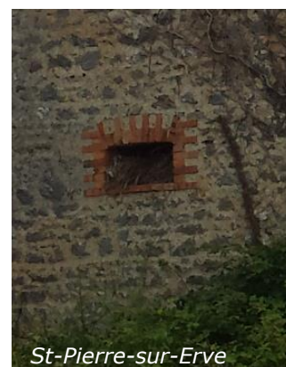
Encadrement des ouvertures en briques (Source : Even Conseil)
