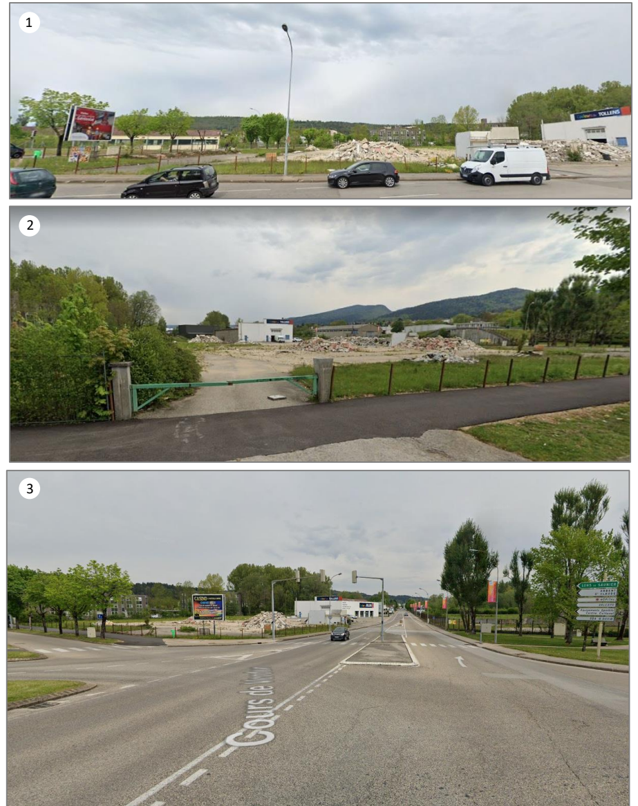
Figure 4. Vues du site
