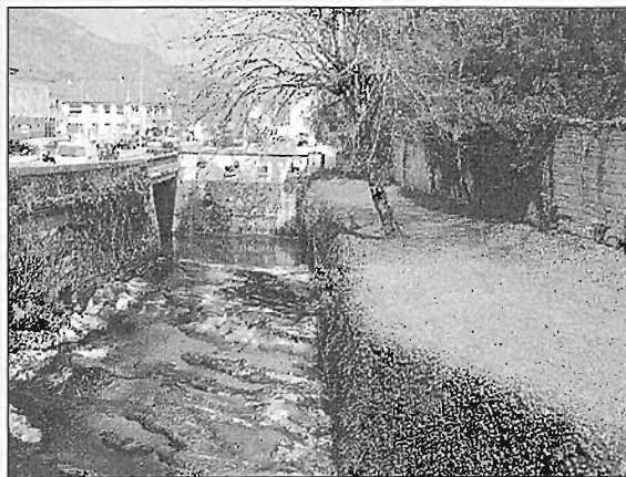
Merdanson : Pont sur la RD31 vue amont
