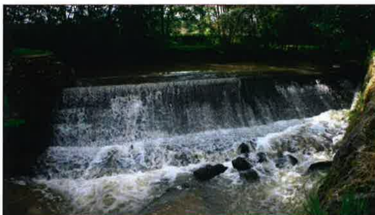
Alaric - Seuil de la dérivation occidentale
