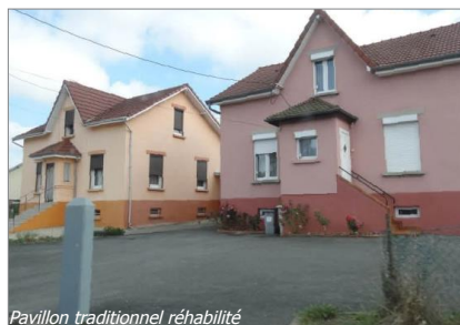
Pavillon traditionnel réhabilité
