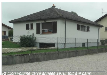
Pavillon volume carré années 1970, toit à 4 pans
