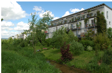
Traitement de l'eau pluviale et aménagement paysager
