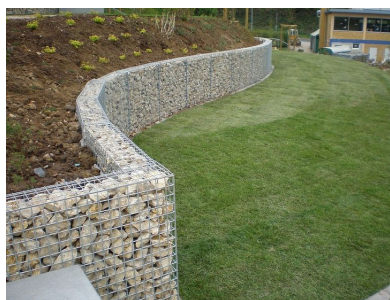
Muret en gabion
