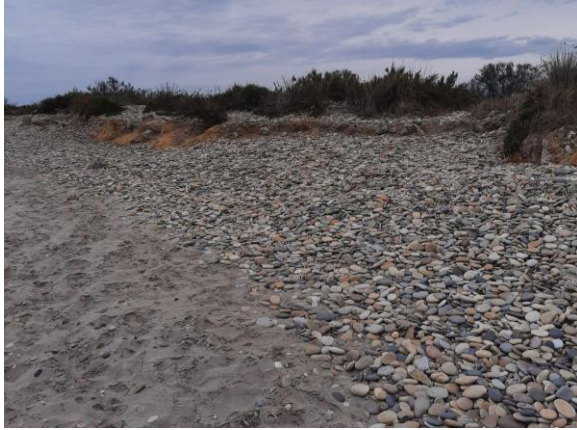
Illustration 67 : Un ancien ouvrage ruiné impacte toujours le transport sédimentaire ; ici les sédiments sont accumulés au pied de l'ouvrage jusqu'à ce qu'ils passent par-dessus. (Villeneuve-lès-Maguelone, SaVE, 2023).
