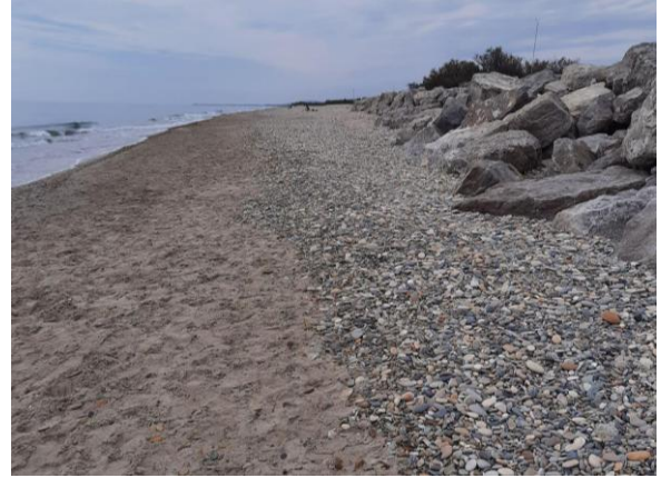
Illustration 68 : Autre exemple d'un vieil enrochement sur le lido de Villeneuve-lès-Maguelone, en voie de ruine, et du blocage sédimentaire à ses pieds (SaVE, 2023).
