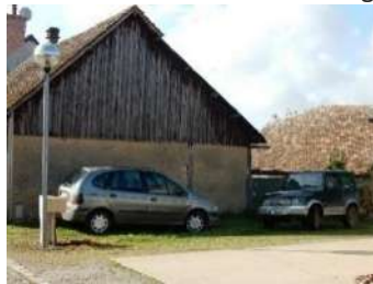
Cré-sur-Loir – Bardage lame de bois
