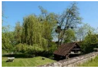
Lavoir_ La Fontaine-Saint-Martin
