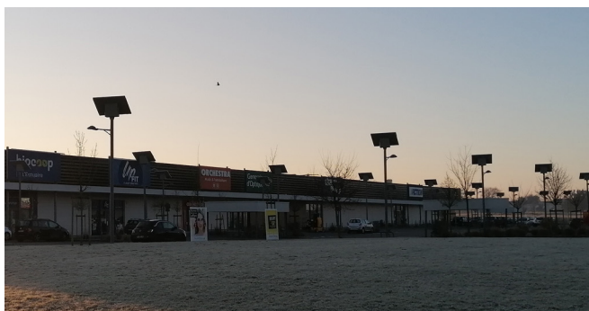
Parking à Cars avec ombrières photovoltaïques - Cittànova janvier 2022
