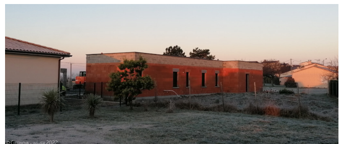
Construction en cours à Blaye route de Sainte-Luce - CITTANOVA 2022
