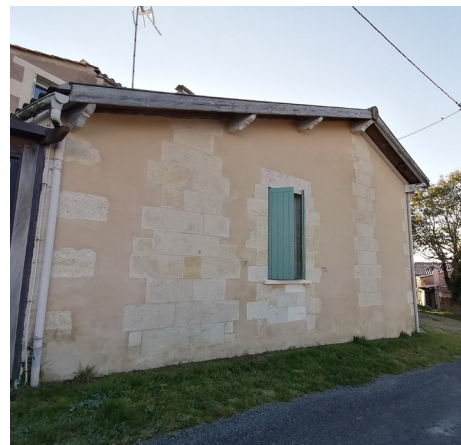
Façade à Berson, source : Cittànova janvier 2022
