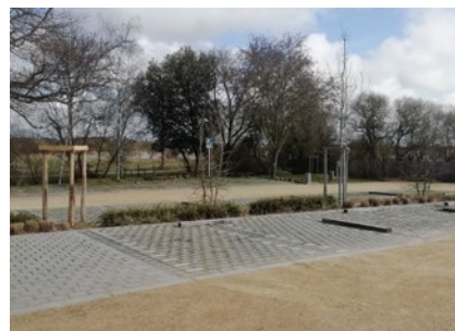
Noue végétalisée et espace semi-perméable (Source : Cittànova St Nazaire mars 2023)
