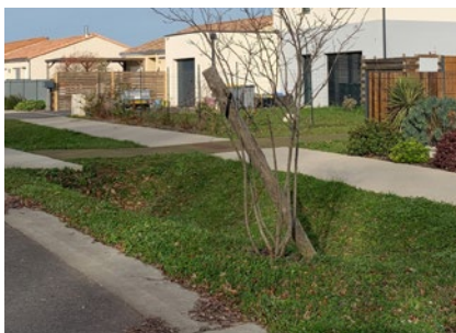
Noue végétalisée avec infiltration gravitaire (Source : Cittànova Saint-Père-en-Retz 06.12.2023)
