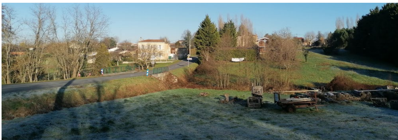
Voie d'eau avec seuil sous la route (source : Cittànova Berson 24.01.2022)
