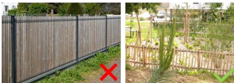
Exemples de clôtures non perméable et perméable (Source : Cittanova)
