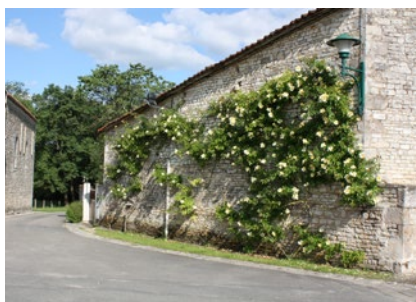
Murs végétalisés (source : Cittànova)
