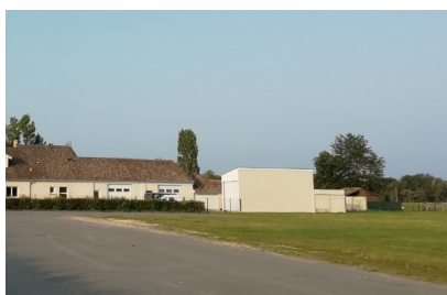
Construction d'un garage individuel (Saint-Girons)
