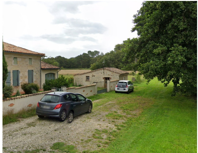
Cabane viticole à Gênerac (source : Google street view)
