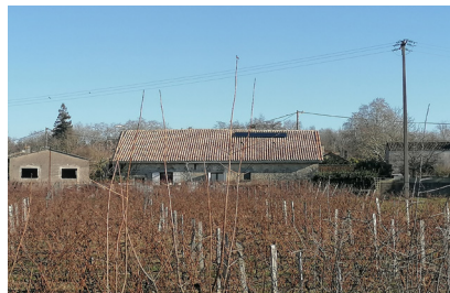
Panneaux photovoltaïque en toiture (Saint Gènes de Blaye)
