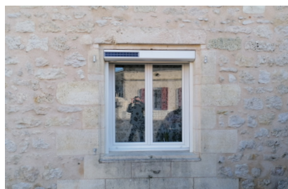
Baie contemporaine sur du bâti en pierre (Saint-Martin Lacaussade)
