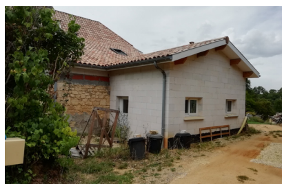
Extension de maison individuelle (Comps)
