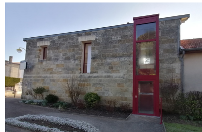
Intégration d'un monte charge en façade (Gauriac)
