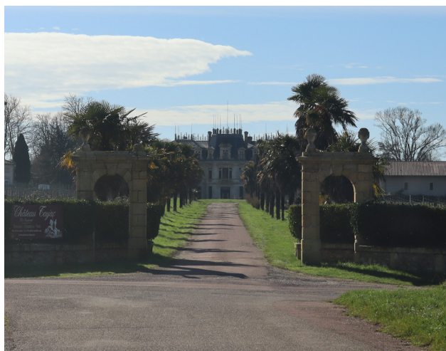
Château Tayac à Saint-Seurin-de-Bourg (source : Cittanova)
