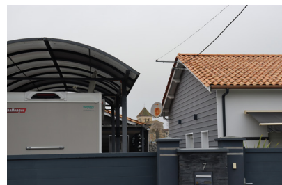
Carport et rénovation de façade (St Christoly de Blaye)
