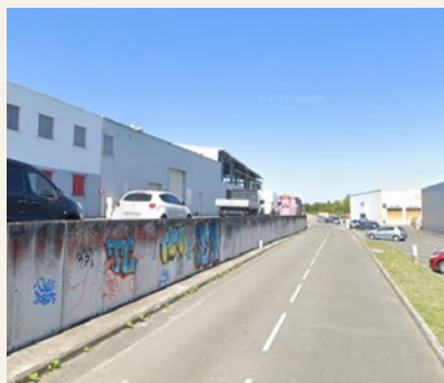
Zone d'activités Boisredon - La Groupe - Sociondeau à Saint-Martin Lacaussade
