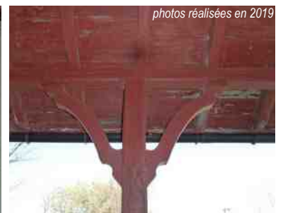
photos réalisées en 2019
