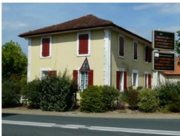
6. Maison de bourg pierre et enduit
