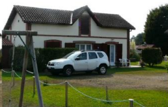
12. Maison Marensine briques et enduit
