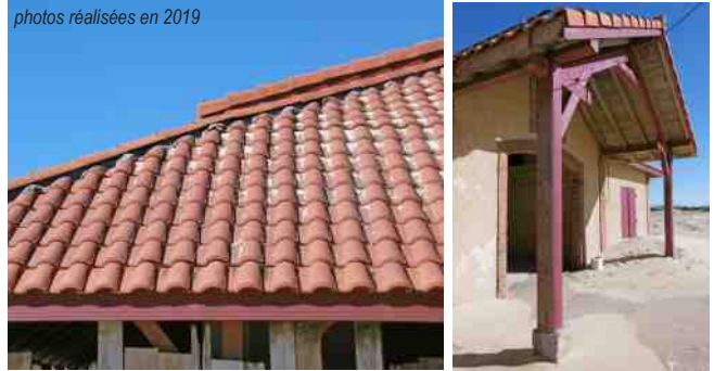
photos réalisées en 2019
