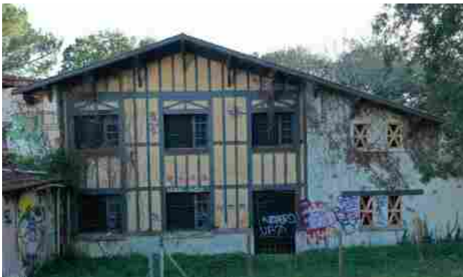
Façade nord bâtiment principal
