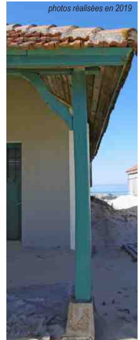
photos réalisées en 2019
