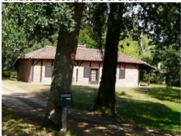
8. Maison rurale d'airial bois et briques
