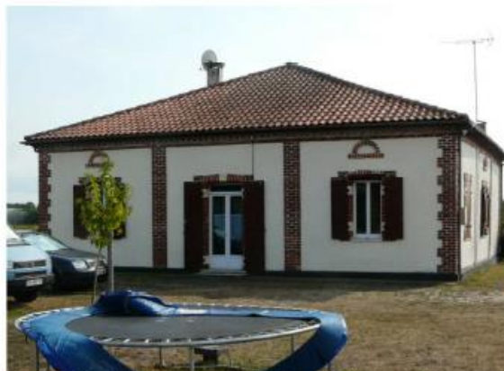
11. Maison Marensine briques et enduit
