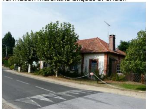
15. Maison Marensin briques et enduit
