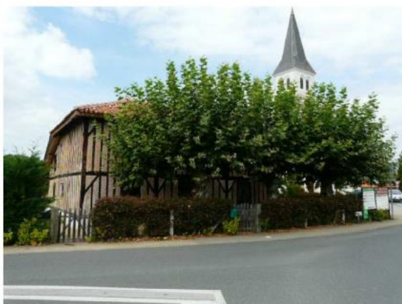
1. Maison de bourg face à l'église
