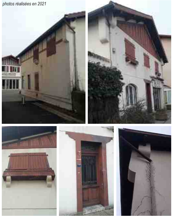
photos réalisées en 2021
