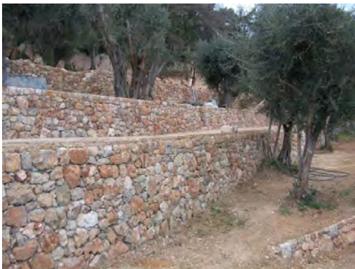
Aménagement de terrasses par des murs à pierres sèches
