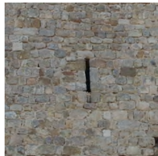
Maçonnerie de moellons taillés destinés à rester apparents
