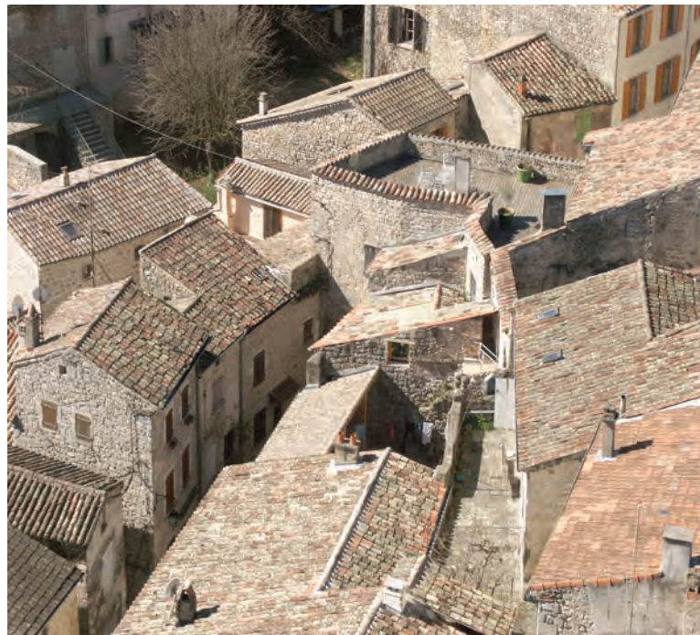
Quartier du Barry, les couvertures en tuiles canals sont majoritaires, quelques terrasses en toiture apparaissent
