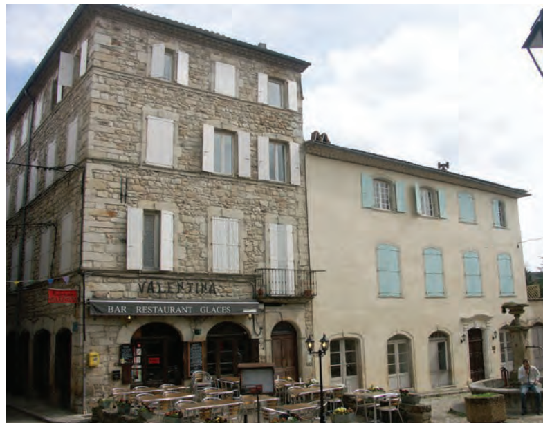
Confrontation place de la Peyre entre enduit et maçonnerie jointée
