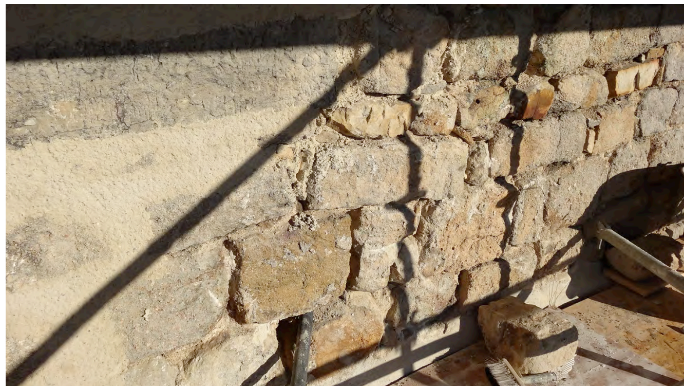
Exemple d'une façade en cours de restauration, à gauche le jointoiement largement beurré, compte tenu de l'état de la pierre, est achevé, au centre les joints dégarnis suffisamment et lavés, à droite le dégarnissage des joints en cours avec le nettoyage de la pierre.
