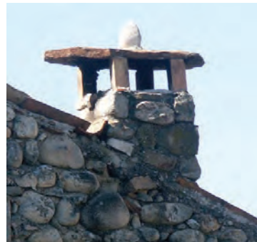
Cheminée près du faitage, couverture par deux tuiles canals ou par une lauze
