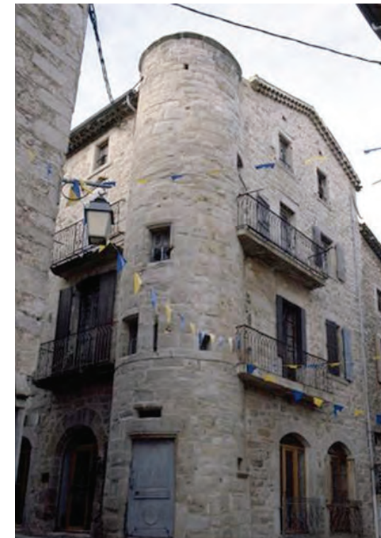
Bâtiment avec tourelle d'angle, n°440 Médiathèque de l'architecture et du patrimoine Ministère de la culture - Base Mémoire
