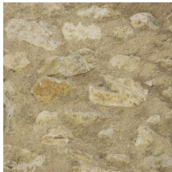
Jointolement à joints garnis ou à « pierres vues » sur une maçonnerie à en moellons tout venant
