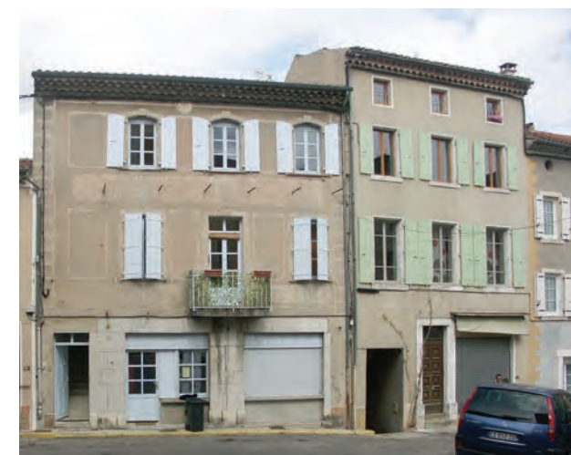
Façades ordonnancées du bâti XIXe place de la Recluse
