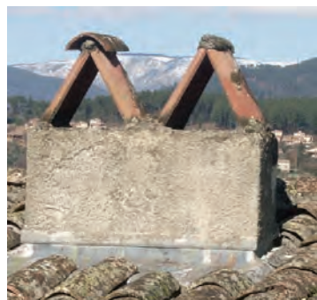
Cheminée près du faitage, couverture par deux tuiles canals ou par une lauze
