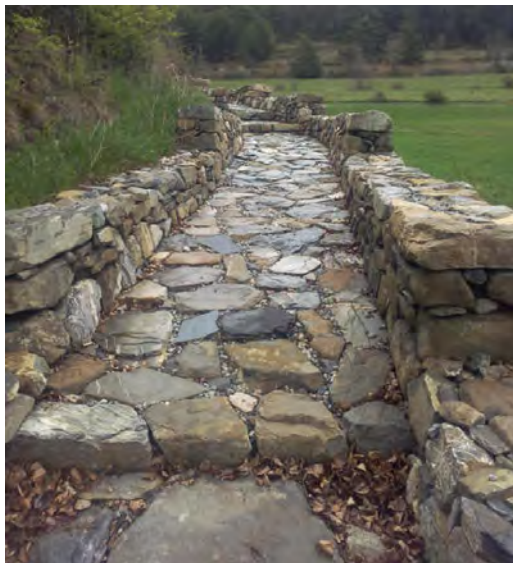
Exemple de cheminement dallé entre des murs en pierres sèches
