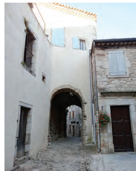
Passage rue de la Gaudinelle
