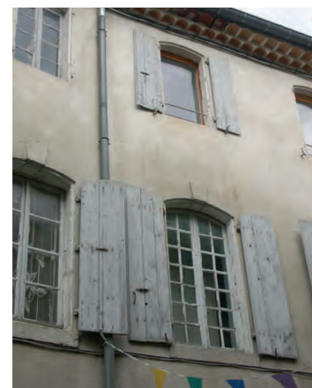
Différentes menuiseries rue de la Recluse
