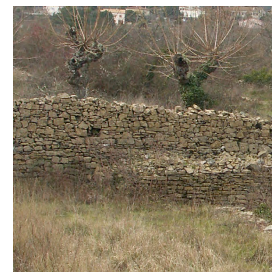
Mur de pierres sèches à restaurer, quartier du Planas entre des parcelles agricoles
