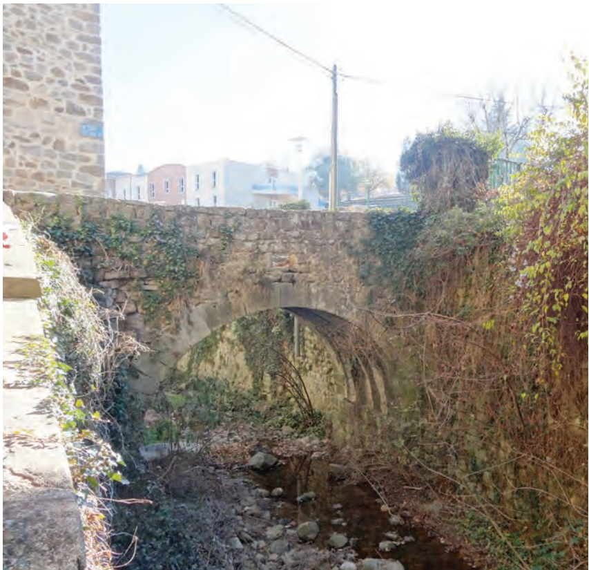
Le pont de la descente du Barry franchissant le ruisseau du Bourdary
