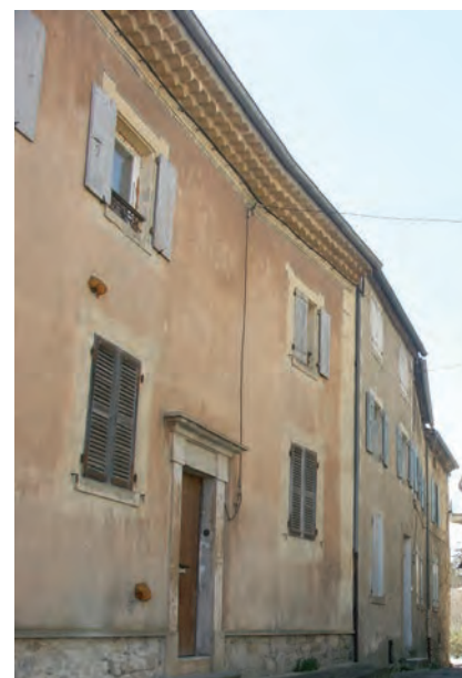
Façades enduites, rue du Docteur Pialat
