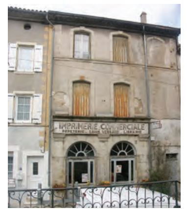
Façade de l'immeuble place de la Recluse
