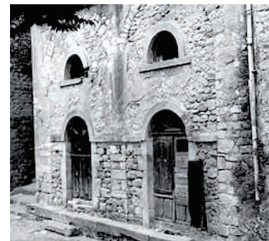
Rez de chaussée place du Barry cliché de 1962 Source: Simone Montaud-Berthelier, Médiathèque de l'Architecture et du Patrimoine
