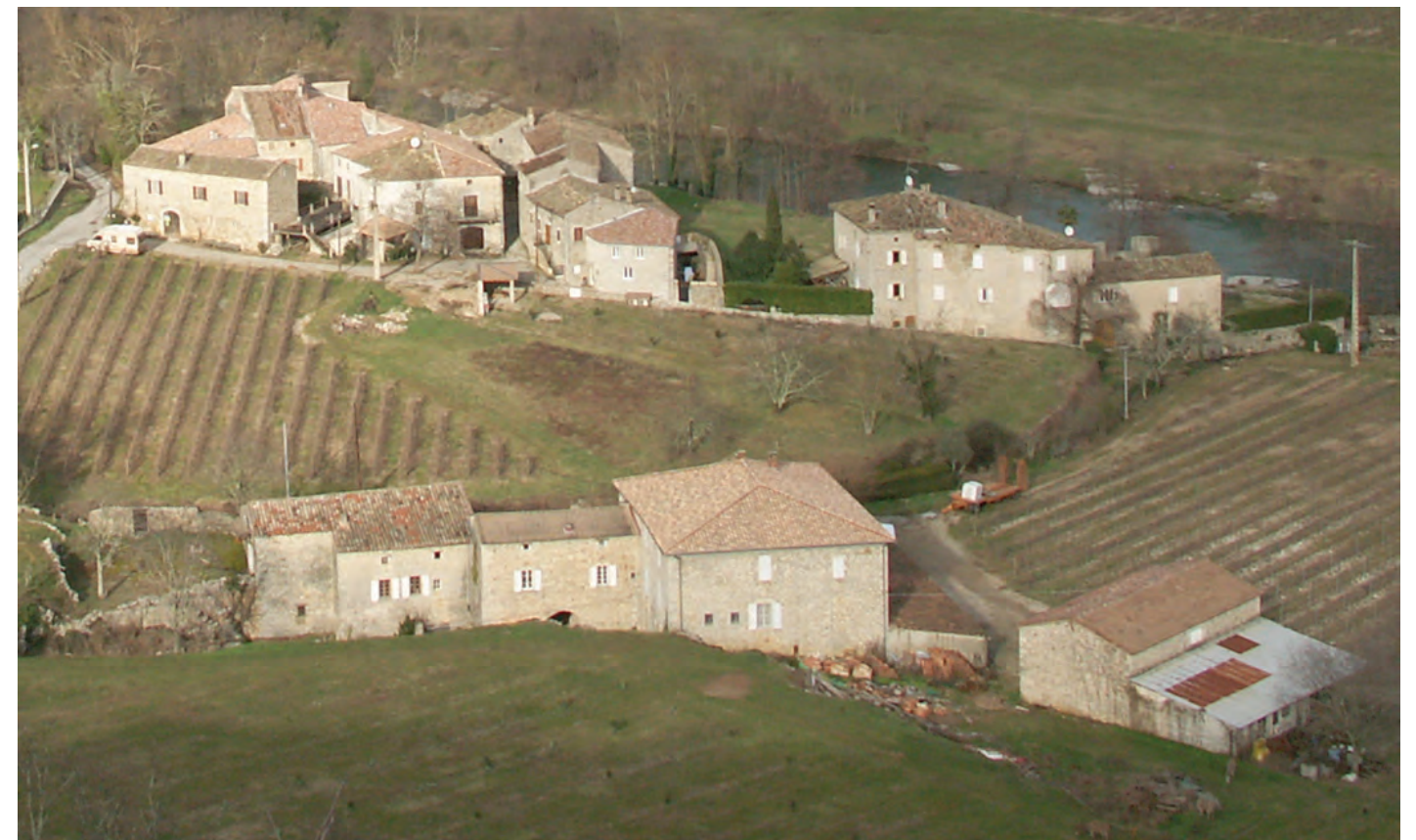
Le hameau de Garel en bordure de La Baume se compose de plusieurs groupes de volumes bâtis. Bien qu'enchevêtrés ils restent distincts et présentent les différents types de bâtiments ruraux : hauts et étroits couverts avec un toit à deux versants, ils se complexifient avec les extensions successives pour former des masses imposantes nécessitant une toiture à 4 versants. Les façades au sud et à l'ouest sont bien composées par les alignements de baies.
