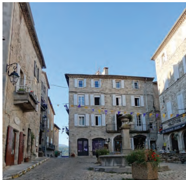
Immeuble de taille et gabarit importants en centre ancien
