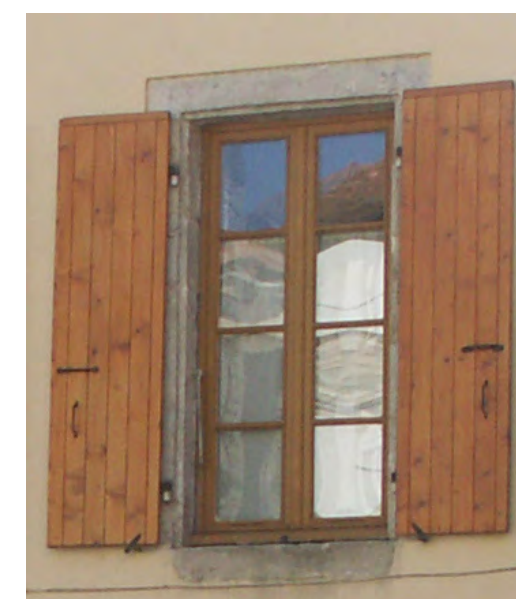
Menuiserie dont la proportion est en adéquation avec la taille et le caractère de la baie, ici partition de vantail en 4 carreaux ; les volets sont à lames droites avec une pièce de bois rapportée en tête pour protéger les lames des eaux de pluie
