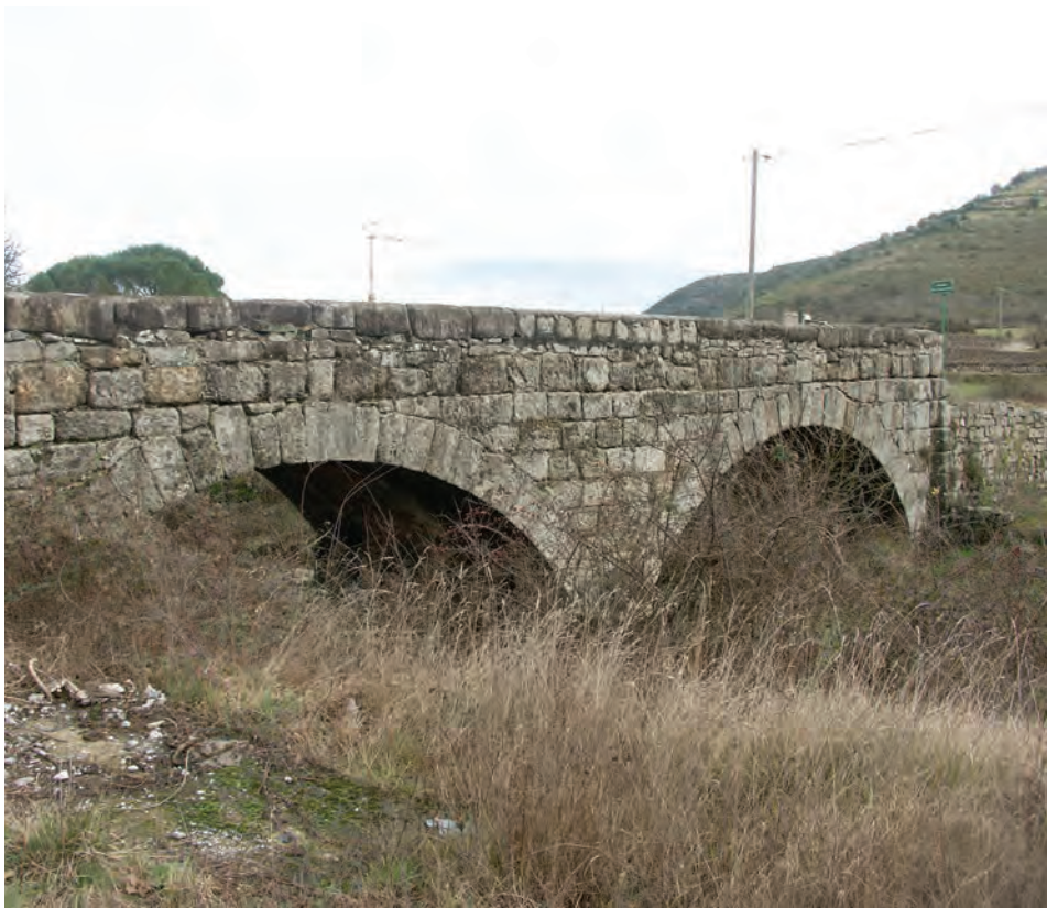
Pont franchissant le ruisseau temporaire de la Cheysette. Le pont lie Joyeuse au hameau du Freyssinet
