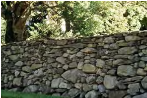
Exemple de murs en pierres sèches
