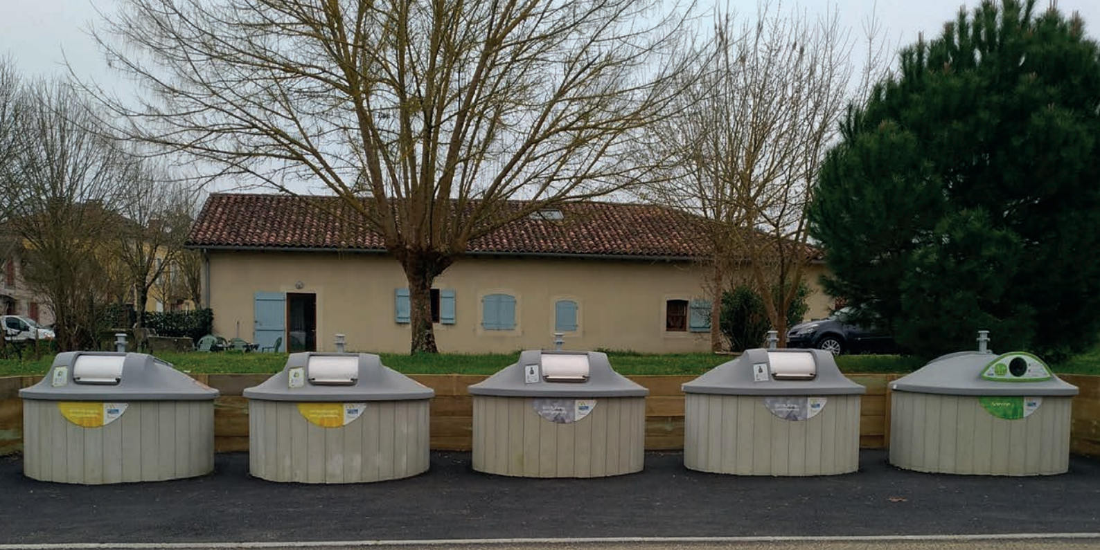
Conteneurs semi-enterrés situés à St Justin
