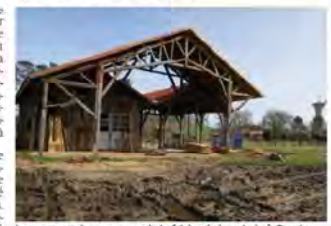
La reconversion en cours de la friche de la scierie à Garsin, qui laissera place à un nouveau quartier aux portes du bourg.
