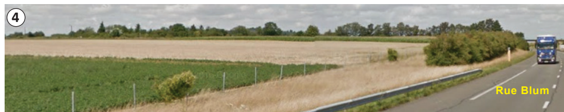
Vue vers le site depuis l'A26 au sud-est. Le talus, la topographie et la présence de linéaires végétalisés le long de l'autoroute et de la rue Blum masquent l'ensemble des perspectives visuelles vers la zone. La zone se trouve derrière la barrière végétale en arrière-plan.
