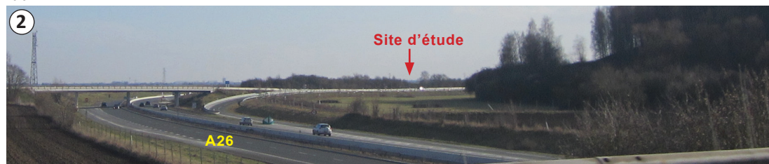
Vue vers le site depuis le pont de la RD65 passant au dessus de l'A26 au nord-ouest. Le site n'est pas visible depuis ce point surplombant la zone. Le pont autoroutier de la sortie combiné à la végétation bordant la zone (autour de l'ancien cavalier) empêchent les vues vers la zone.
