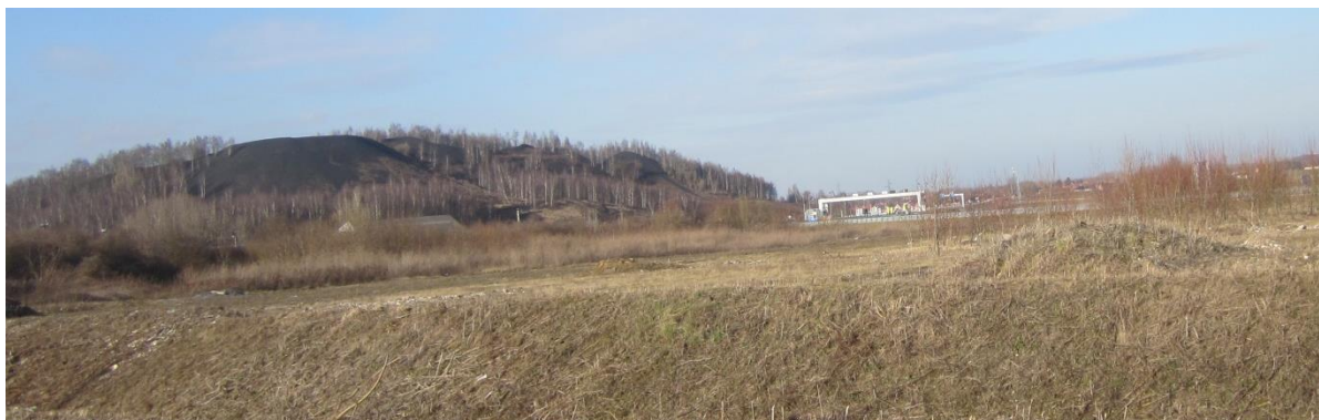
Covisibilité entre le péage et le terril depuis le carrefour giratoire à l'est de la ZI
