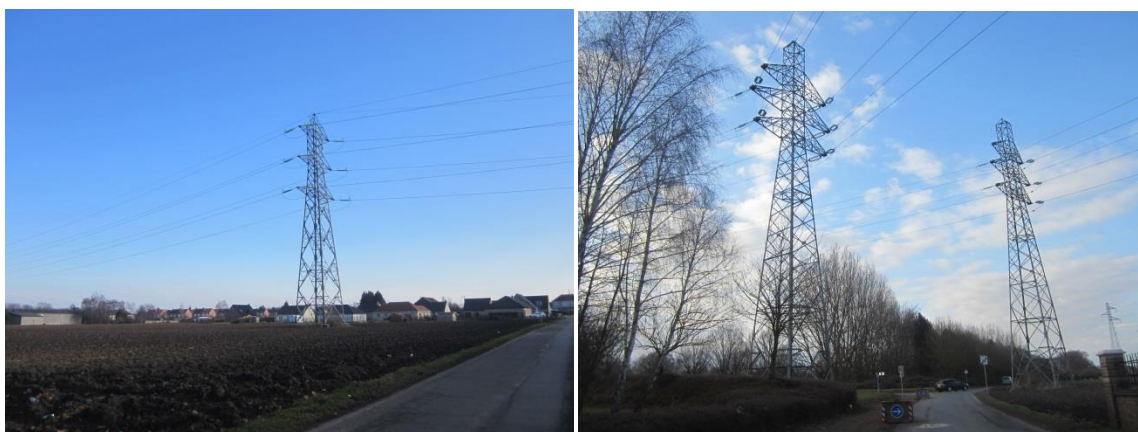
Les pylônes et la ligne électrique
