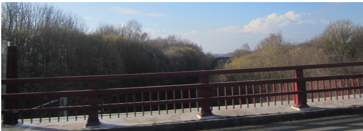
La voie ferrée – peu dévalorisante du paysage car encaissée et accompagnée d'une végétation dense
