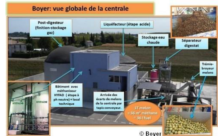
Unité de méthanisation en 2 étapes de la société Boyer, basée à Moissac, utilisée pour le traitement de ses déchets de melons (82) - crédit photo : Boyer
