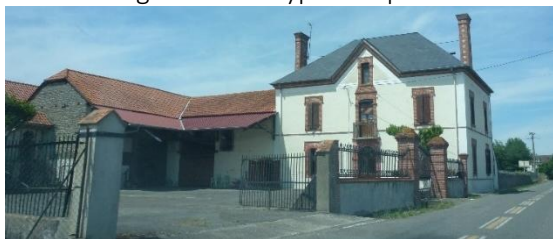
Bâtiment en « L » implanté le long de la voie dans le noyau villageois d'Ugnouas
