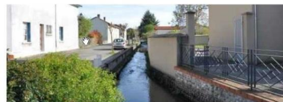
Canaux à l'aplomb du bâti à Maubourguet
