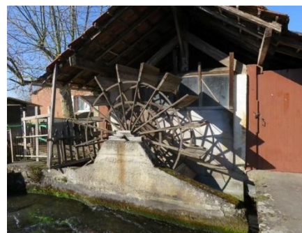
Petit patrimoine lié à l'eau (Moulin et lavoir)
