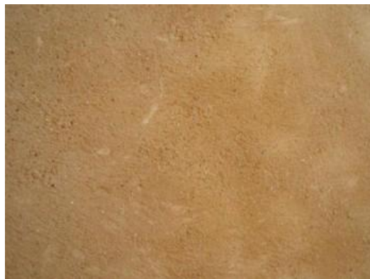
Exemple d'enduit de finition à la chaux
