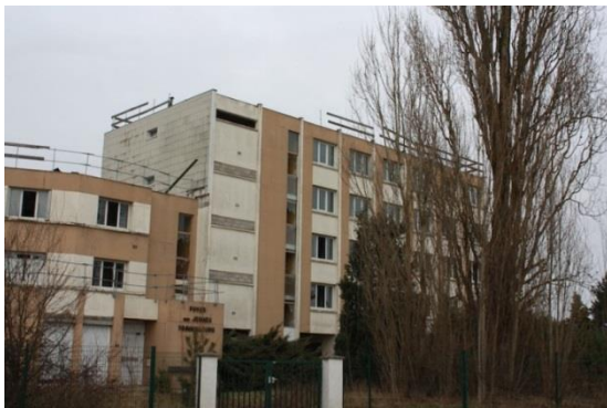
Photo 1 : Ancien Foyer des jeunes Travailleurs – démolition en 2017
