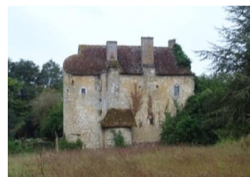
Figure 189 : le vieux château du Moulinet-sur-Solin
