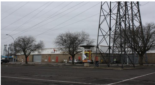
Photo 2: ancien centre commercial
