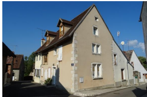
Figure 157 : Saint-Gondon, bâtiment R + 1 + combles
