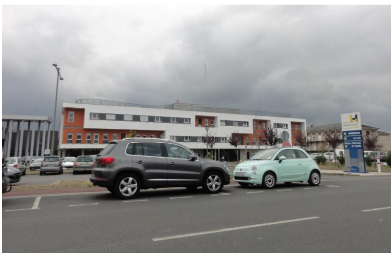
Photo 4: Centre hospitalier de Gien
