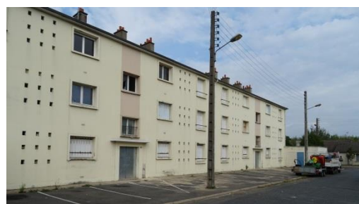
Figure 112 : Immeuble inoccupé aux abords du lycée
