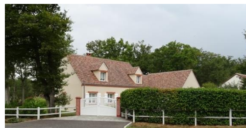
Figure 168 : Pavillon récent à Boismorand
