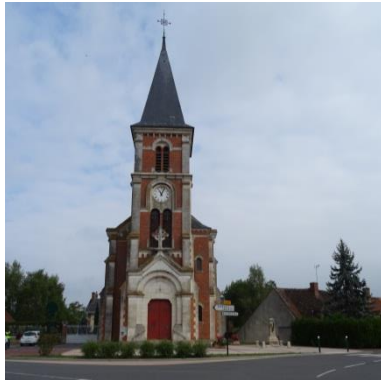
Figure 150 : Les Choux, place de l'Eglise
