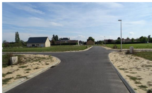
Figure 216 : Les extensions récentes avec rupture urbaine
