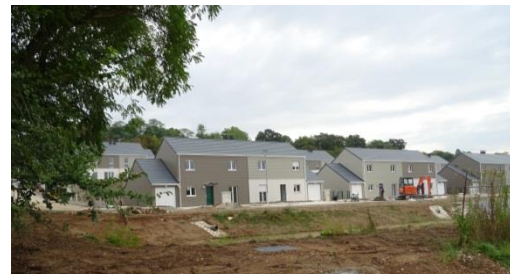
Figure 174 : Dernières constructions groupées de Nevoy
