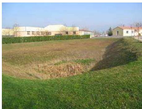
Figure 92 : bassin de rétention en forme de noue
