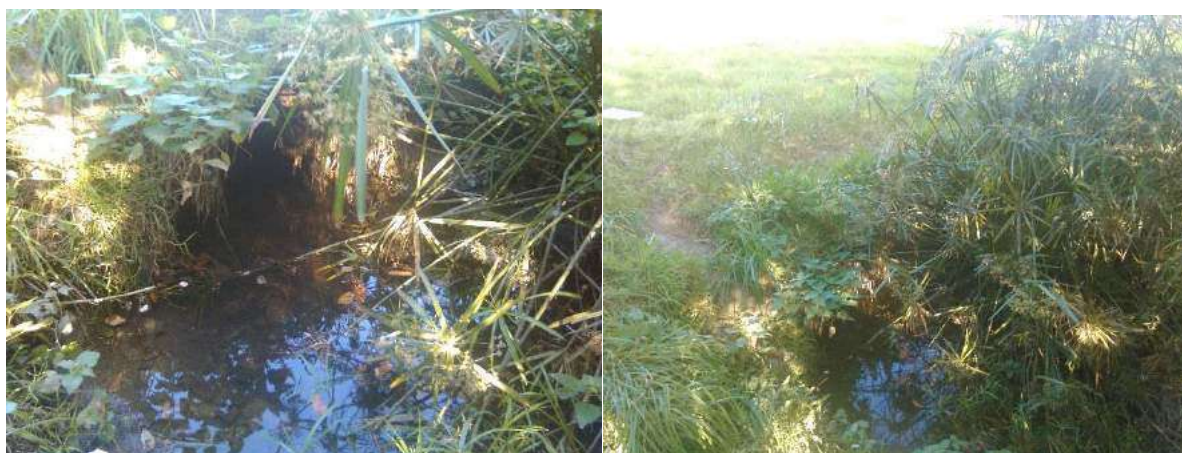
Figure 63 : Exutoire du Parc Paysager en charge (zoom) et vue d'ensemble
