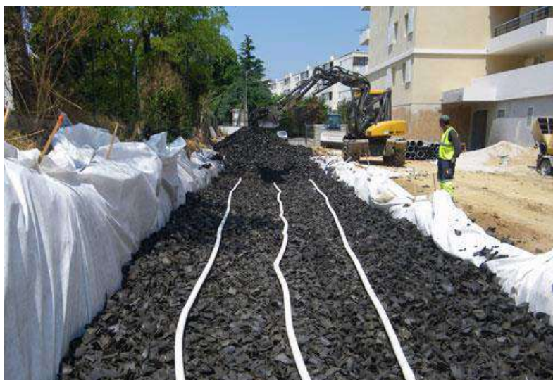
Figure 89 : exemple de dispositif d'infiltration des eaux pluviales
