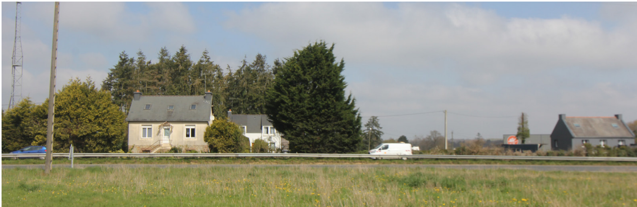
Vue des quelques maisons à proximité directe de la RN12, faisant face au site de Coat An Doc'h. Tissus urbanisé diffus.
