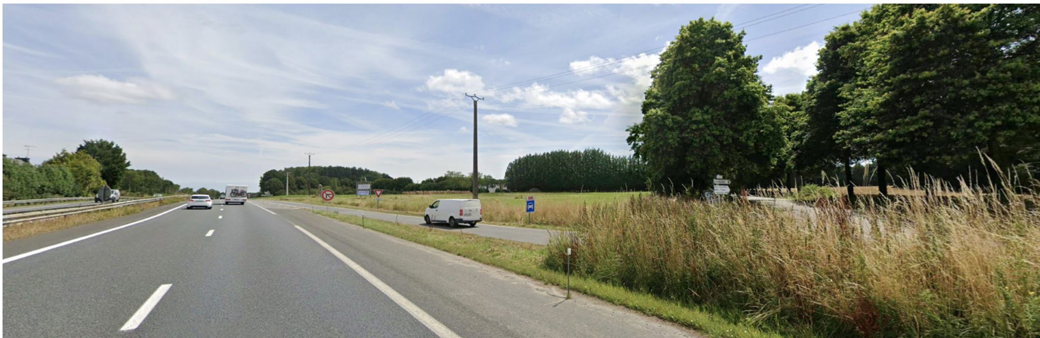
Vue dans le sens Guingamp -> Rennes sur la partie ouverte avec les alignements de la voie communale et la bretelle d'accès en premier plan
