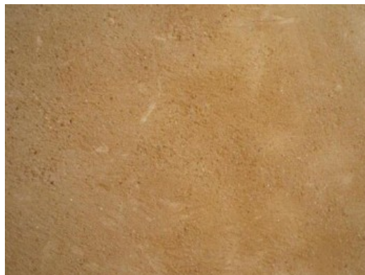
Exemple d'enduit de finition à la chaux
