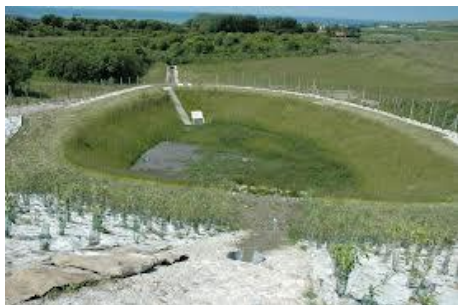
Bassin de rétention
