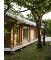
Couvertures métal peintes gris de type bac acier ondulé
