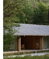
Couvertures métal peintes gris de type bac acier ondulé
