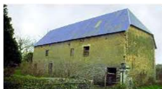
Pignon réduit par une queue de geai
