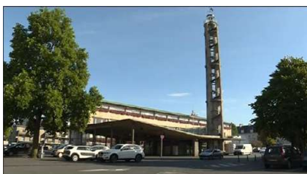
La halle et le beffroi de Saint-Lô
