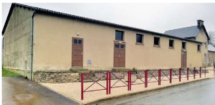
Salle de convivialité avant travaux de rénovation à Lozon ; Manche Libre
