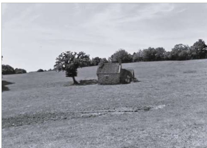
Exemple - four à pain à Tessy Bocage
