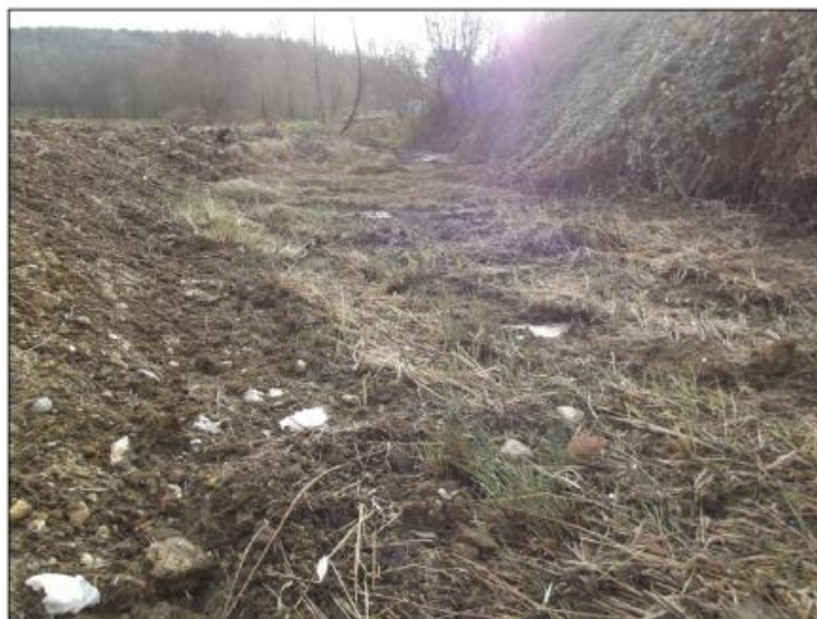
Photographie 7 : Fosse de rétention des eaux pluviales de la RD1083
