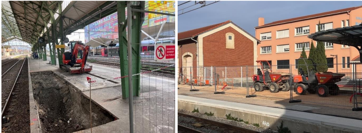
Figure 10 : Travaux de mise en accessibilité des quais A et B de la gare de Perpignan (AURCA, 2024).
