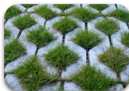
dalle béton alvéolaire avec gazon
