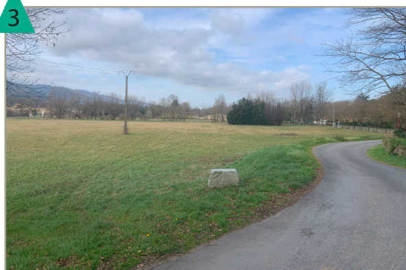
Vue d'ensemble sur la parcelle avec la ligne électrique moyenne tension
