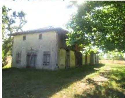
Grange n°1 (ancienne écurie)
