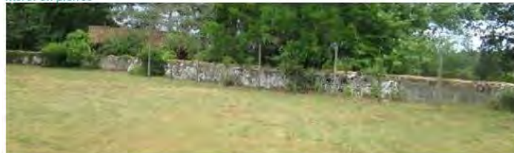
Muret en pierres
