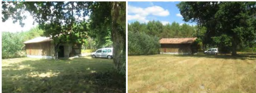
3 : loge à cochons (avec four à pain)
