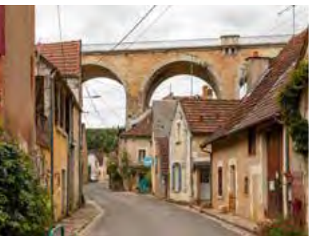
_Viaduc à Ménétréol-sous-Sancerre, crédit JL Garanto_
