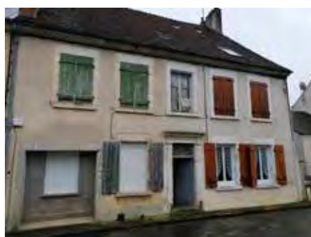
_Modification de la taille d'une ouverture à Ménétréol-sous-Sancerre_
