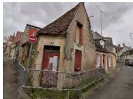
_Construction en ruines à Saint-Satur_
