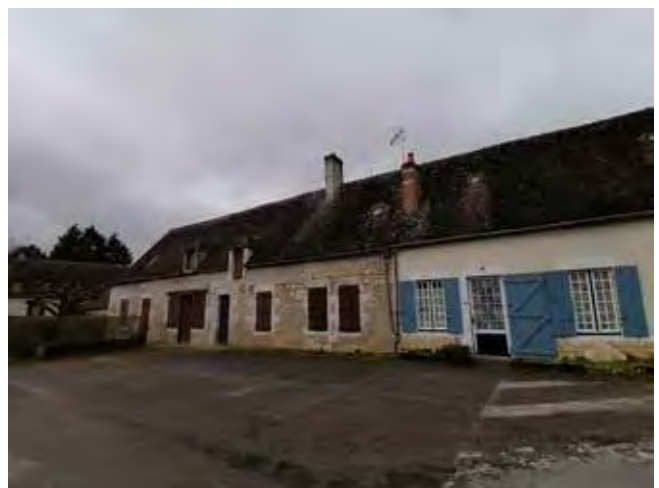
_Exemple dans le bourg de Bannay d'une maison basse en rez-de-chaussée, composée originellement d'une pièce unique se prolongeant par une étable ou une écurie_
