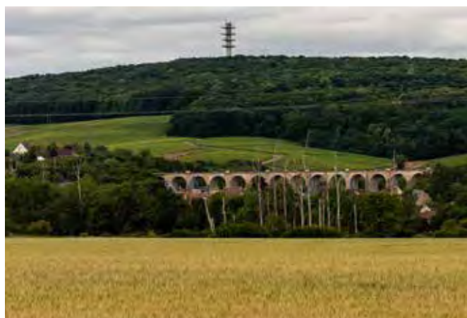
_Vue sur le viaduc de l'Etang à Ménétréol-sous-Sancerre_ crédit JL Garanto
