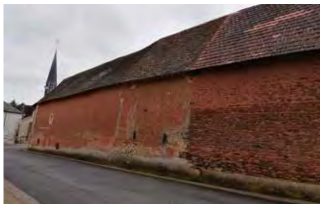
_Utilisation d'un enduit de chaux et de sable à forte coloration rosée, Bourg de Le Noyer_
