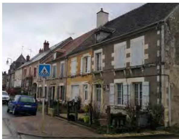
_Exemple dans le bourg de Saint-Bouize de maisons de ville à étage_
