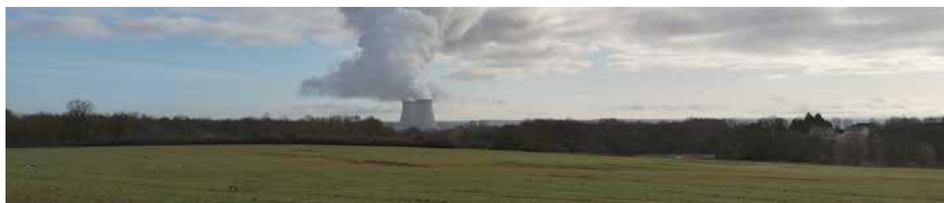
_Vue sur les tours de refroidissement de la centrale nucléaire de Belleville-sur-Loire_
