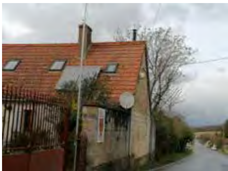
_Panneaux photovoltaïque sur une construction à Feux_
