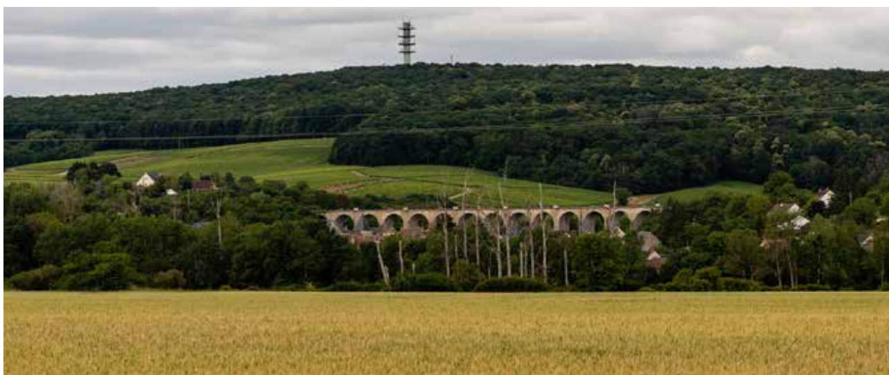
_ Vue sur le viaduc de Ménétréol-Sous-Sancerre, crédit JL Garanto _
