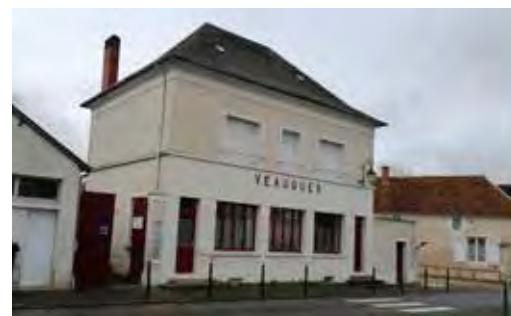
_Site de la maison de santé à Veaugues_
