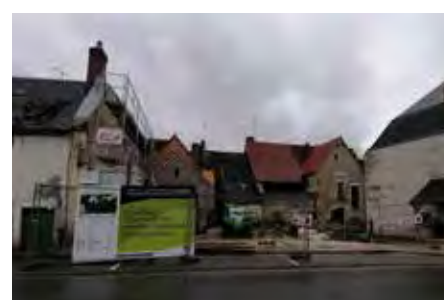
_Halte nautique en construction à Ménétréol-sous-Sancerre_
