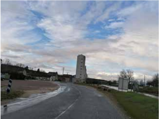
_ Les silos situés dans la partie centrale de la zone (Epis-Centre) _
