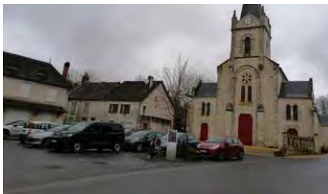
_Stationnement en coeur de bourg, place de l'église à Bué_
