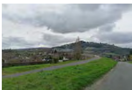
_Le viaduc de Ménétréol-sous-Sancerre accessible uniquement à pied_
