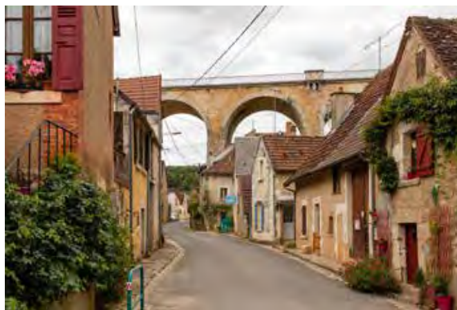
_Bourg et viaduc de Ménétréol-sous-Sancerre, crédit JL Garanto_
