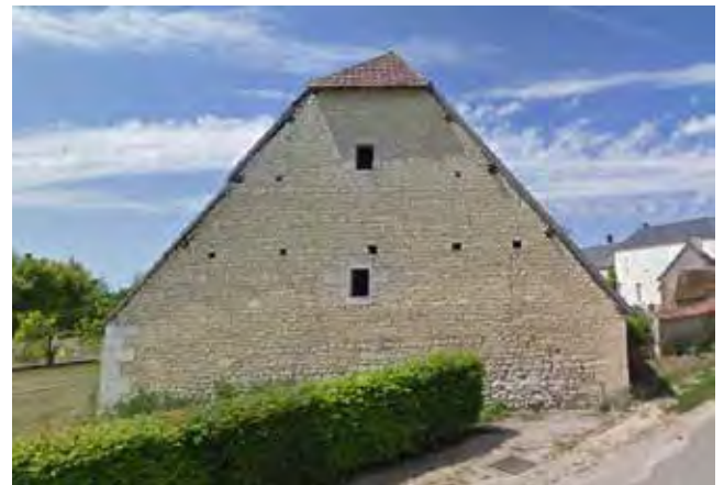
_Exemple dans le bourg de Feux d'une grange_
