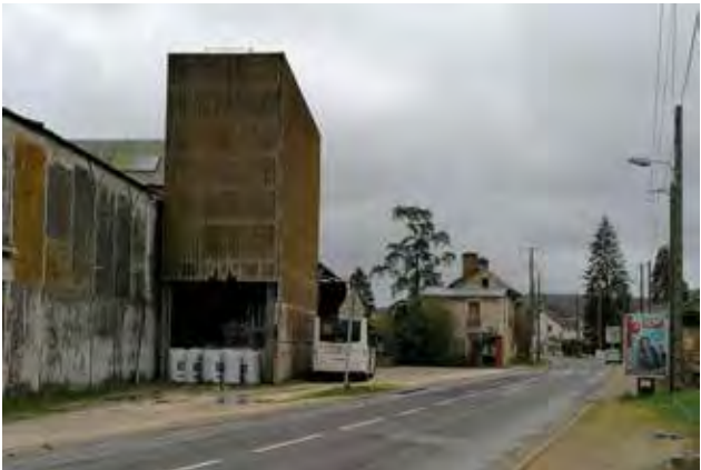
_ Les silos situés dans la partie nord de la zone _
