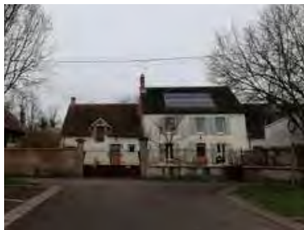
_Panneaux photovoltaïque sur une construction à Boulleret_
