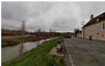
_Aménagement routier des abords de la Loire_
