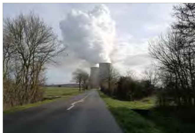
_Vue sur les tours de refroidissement, Belleville-sur-Loire_
