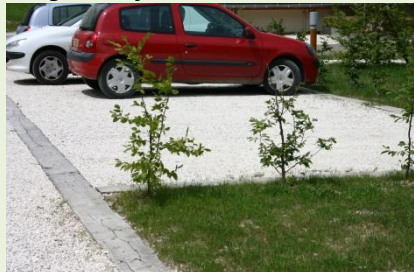
Stationnement végétalisé, revêtement en concassé, marquage et bordure bois [Lans en Vercors-38]
