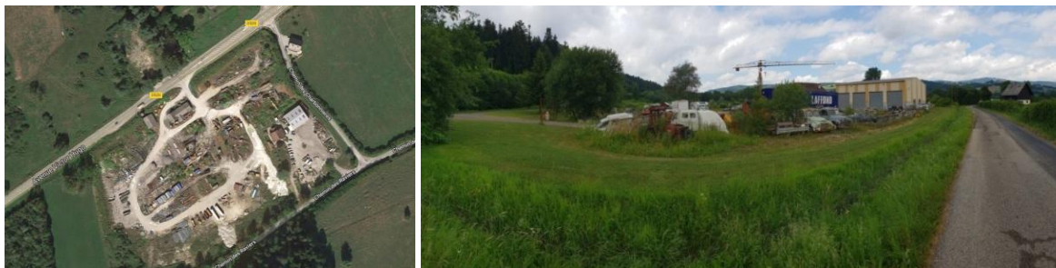
(1) Le site actuel / (2) Front bâti peu qualitatif entre l'avenue Victor Hugo et le Chemin des Charbonnières : non intégré dans le paysage. La grue crée un point noir paysager - Les perceptions depuis la D502 sont peu valorisantes.
