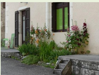
Pied de façade végétalisé
