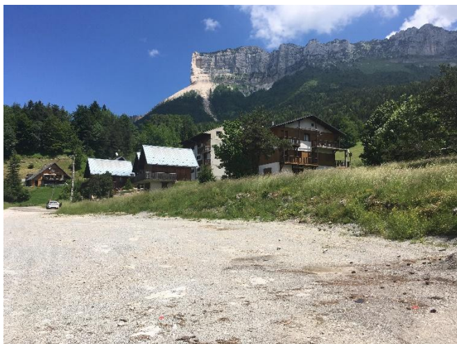
Vue du site vers les constructions existantes
