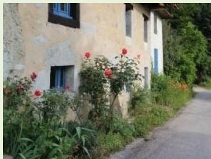
Pied de façade végétalisé
