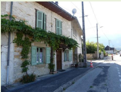
Végétation grimpante en façade
