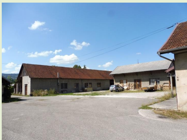
Vue de l'intérieur du tènement de l'ancienne usine
