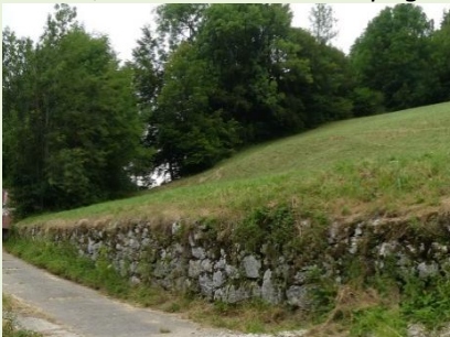
Muret de soutènement en pierres, pied de mur et terrain enherbé
