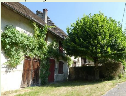
Façade végétalisée (grimpante) et recul en herbe
