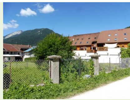
Vue du tènement significatif en centre-bourg (parcelles AE 164 à 166) à l'arrière du front bâti sur le Plan de Ville
