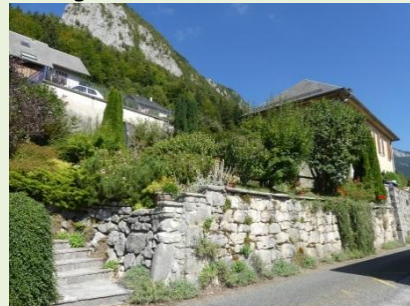
Mur en pierres avec terrasse jardinée
