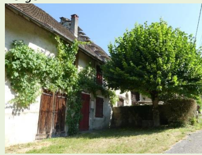
Façade végétalisée (grimpante) et recul en herbe
