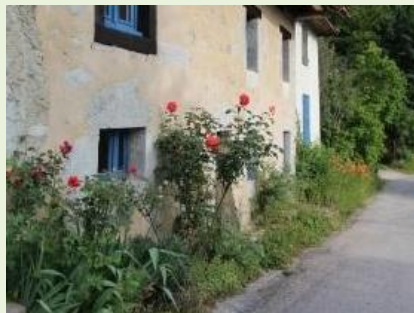
Pied de façade végétalisé
