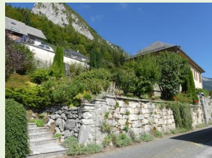
Mur en pierres avec terrasse jardinée
