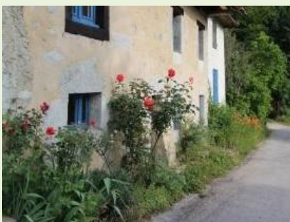
Pied de façade végétalisé
