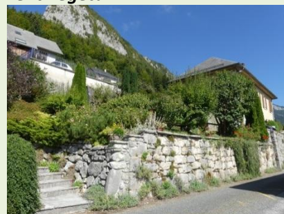
Mur en pierres avec terrasse jardinée
