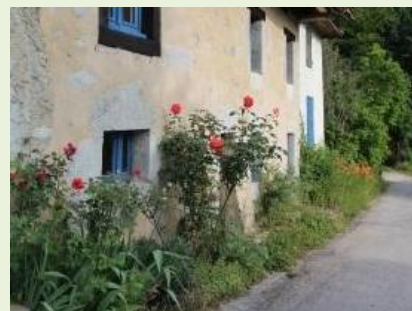
Pied de façade végétalisé
