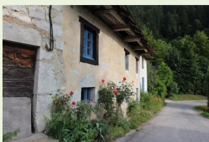
Pied de façade végétalisé
