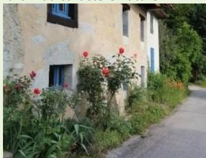
Pied de façade végétalisé
