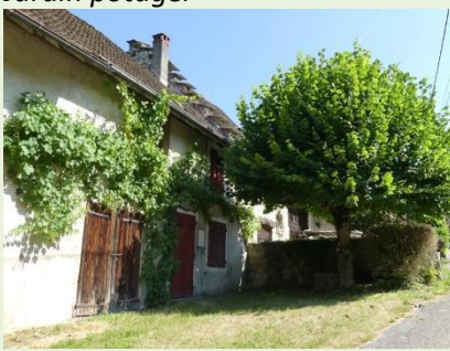
Façade végétalisée (grimpante) et recul en herbe
