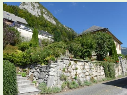
Mur en pierres avec terrasse jardinée
