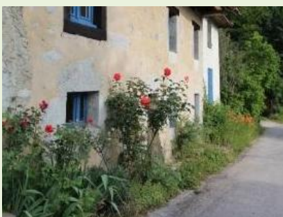
Pied de façade végétalisé
