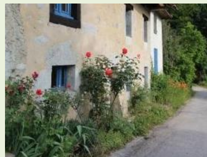
Pied de façade végétalisé
