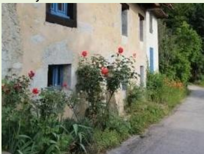
Pied de façade végétalisé
