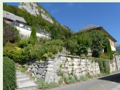
Mur en pierres avec terrasse jardinée
