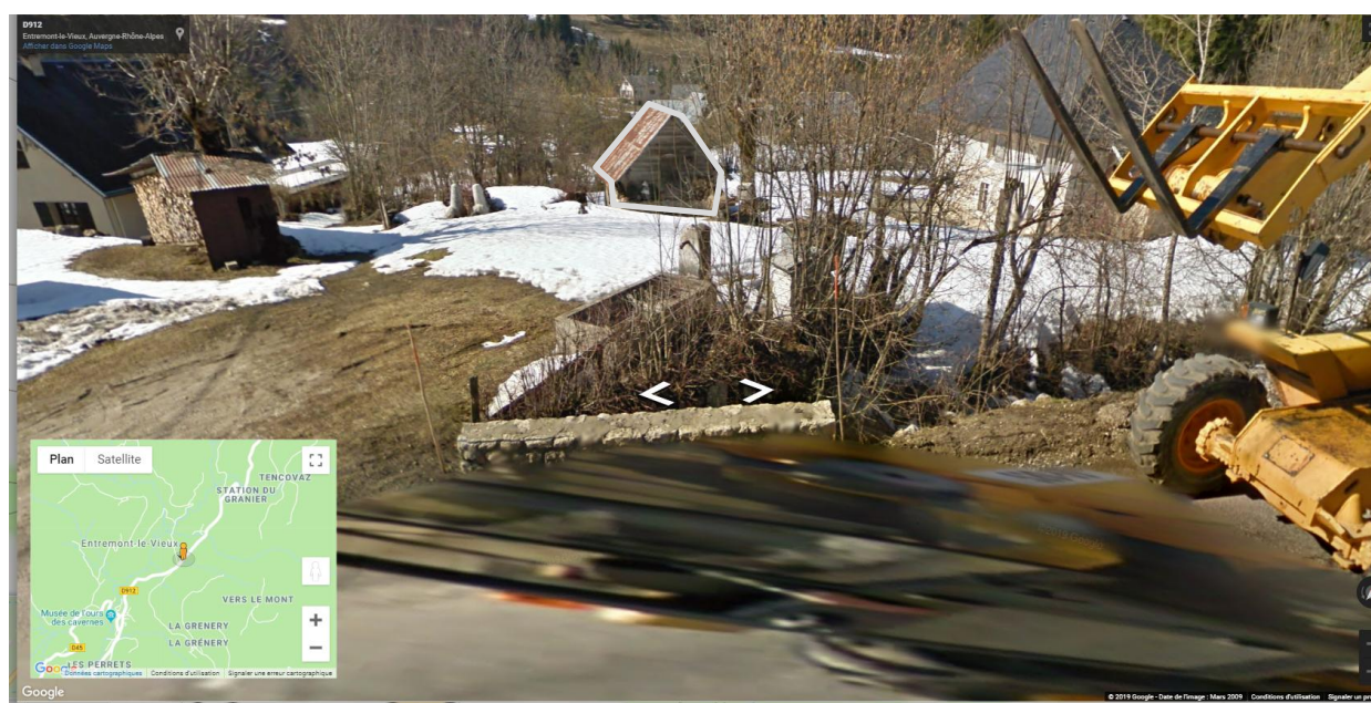
Vue sur le grenier à réhabiliter
