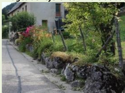
Soutènement léger, 1 ligne de blocs de pierre accompagnée de végétal
