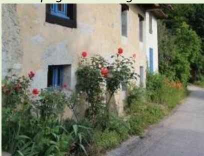
Pied de façade végétalisé
