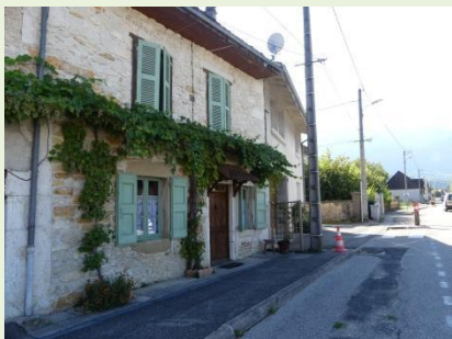
Végétation grimpante en façade
