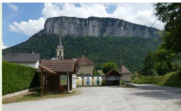
Vue vers l'église et le grand paysage à mettre en scène via l'aménagement de l'aire de stationnement
