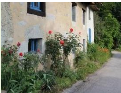
Pied de façade végétalisé
