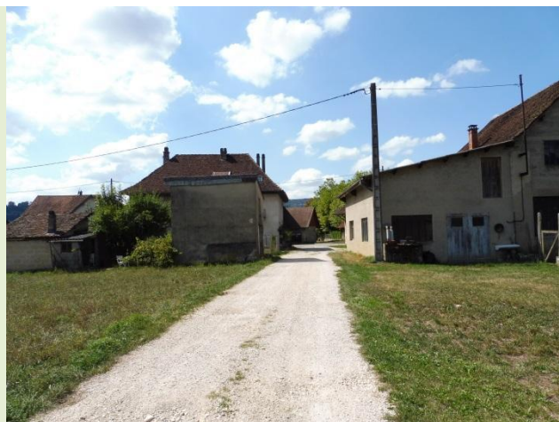
Vue du chemin de la Roche avant de déboucher sur l'Avenue du Montcelet
