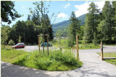
Stationnement végétalisé, revêtement en concassé [Susville-38]
