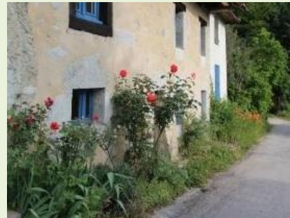
Pied de façade végétalisé
