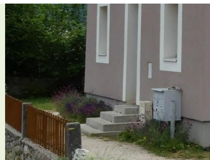
Pied de façade végétalisé
