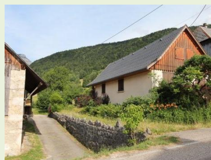
Végétalisation du pied de bâtiment
