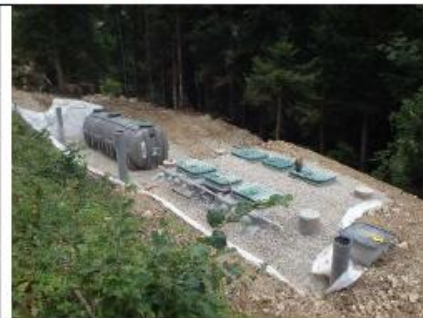
4- Pose de la filière de traitement et remblaiement
