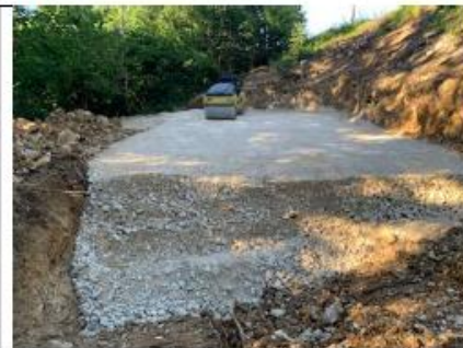
4- Pose de la filière de traitement et remblaiement
