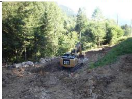
4- Pose de la filière de traitement et remblaiement
